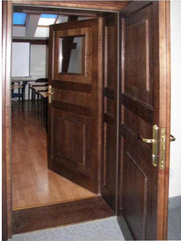
Rys. 1. Drzwi podwójne z progiem, poprawiające izolacyjność między klasą i korytarzem (przykład z Akademii Muzycznej w Gdańsku). Izolacyjność każdego skrzydła nie mniejsza niż R'_{A1}=38 dB. Okno w drzwiach umożliwia wgląd do klasy bez przeszkadzania w zajęciach.
