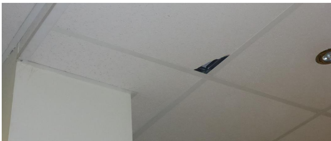
Ubytki w płytach mineralnych sufitu - poziomy parteru i 1 piętra.
