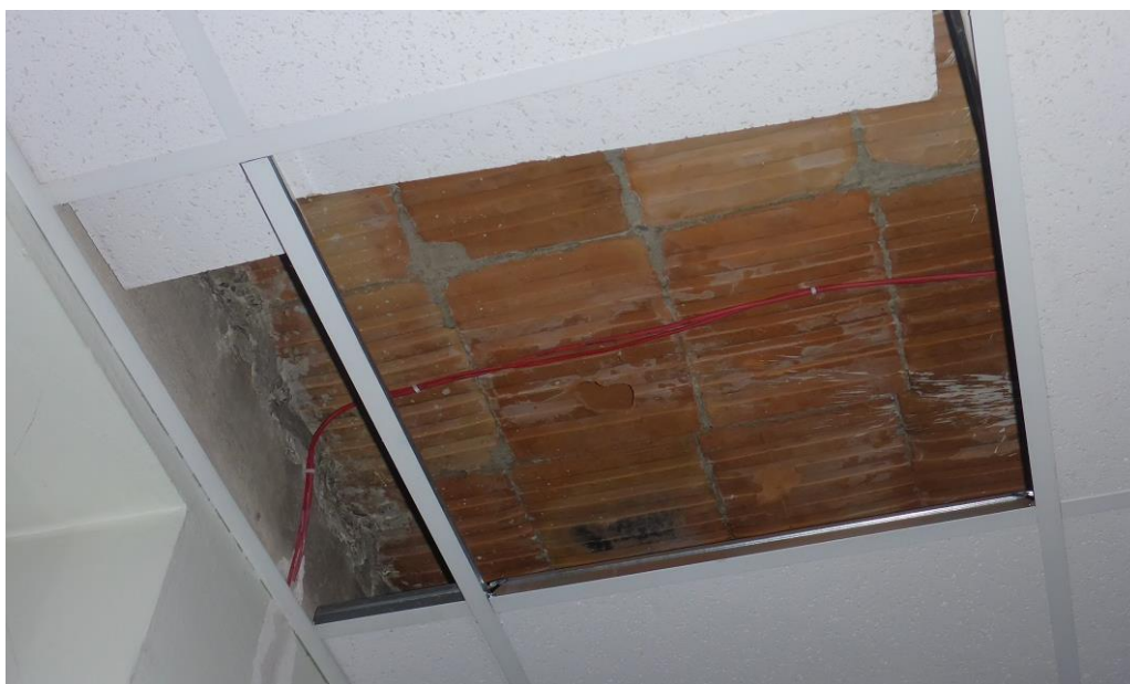
Nieotynkowana dolna powierzchnia stropu właściwego – 1 piętro
