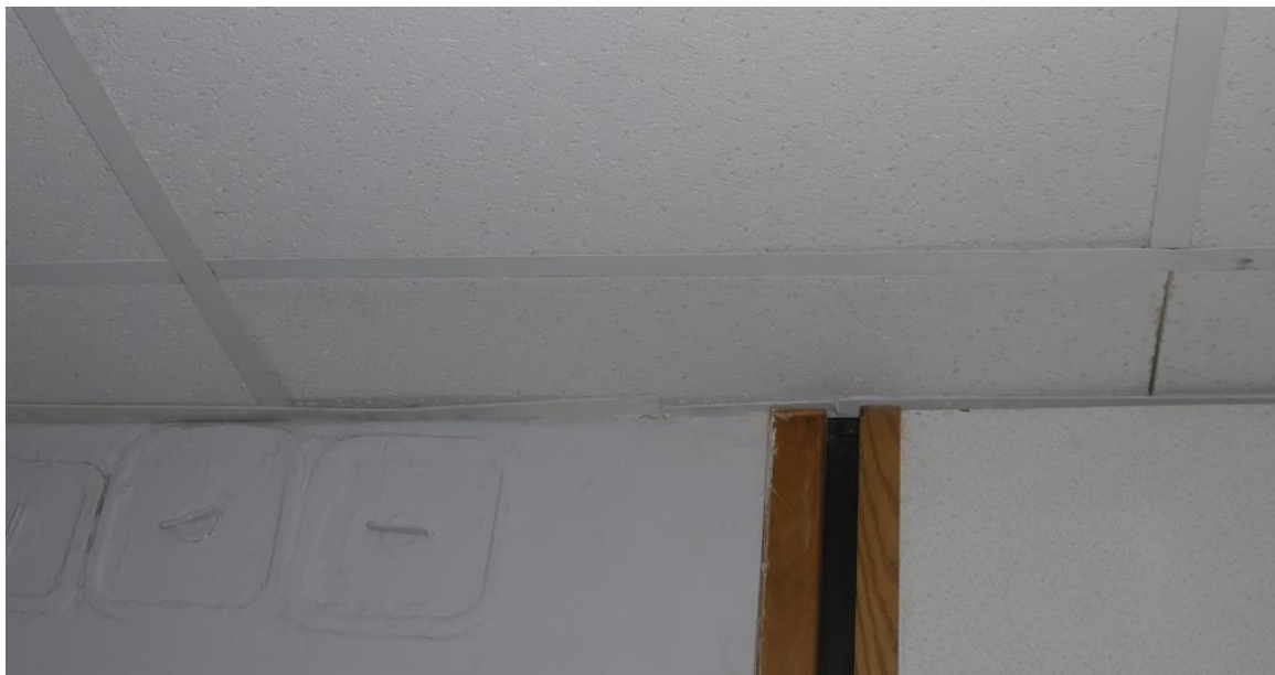
Powyginane i zniszczone listwy konstrukcyjne sufitów – 1 piętro
