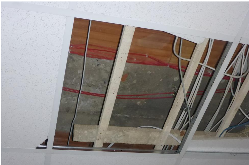
Zamocowanie sufitu podwieszonego do drewnianego rusztu - parter
