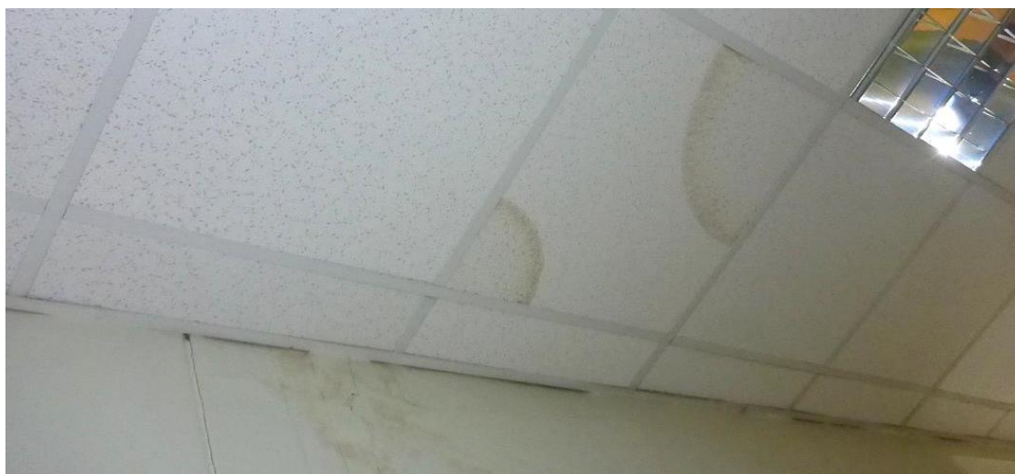
Zacieki na płytach mineralnych na skutek działania wody opadowej 1 piętro.
