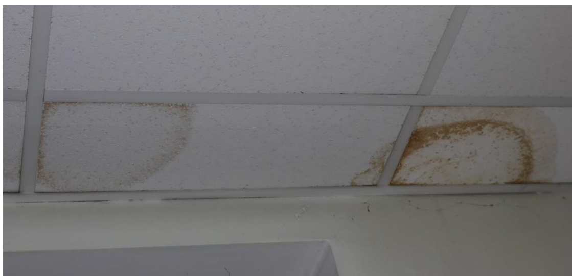
Zacieki na płytach mineralnych na skutek działania wody z instalacji – piwnice -1.
