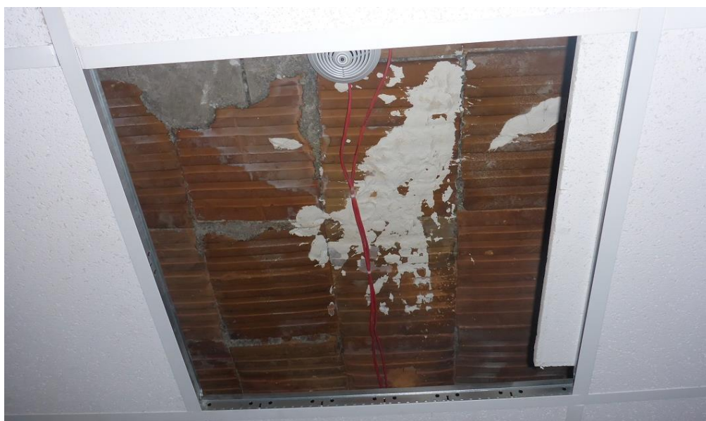
Zamocowanie sufitu podwieszonego do stropu właściwego - parter
