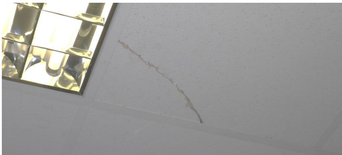
Ubytki i spękania w płytach mineralnych sufitu - poziom parteru
