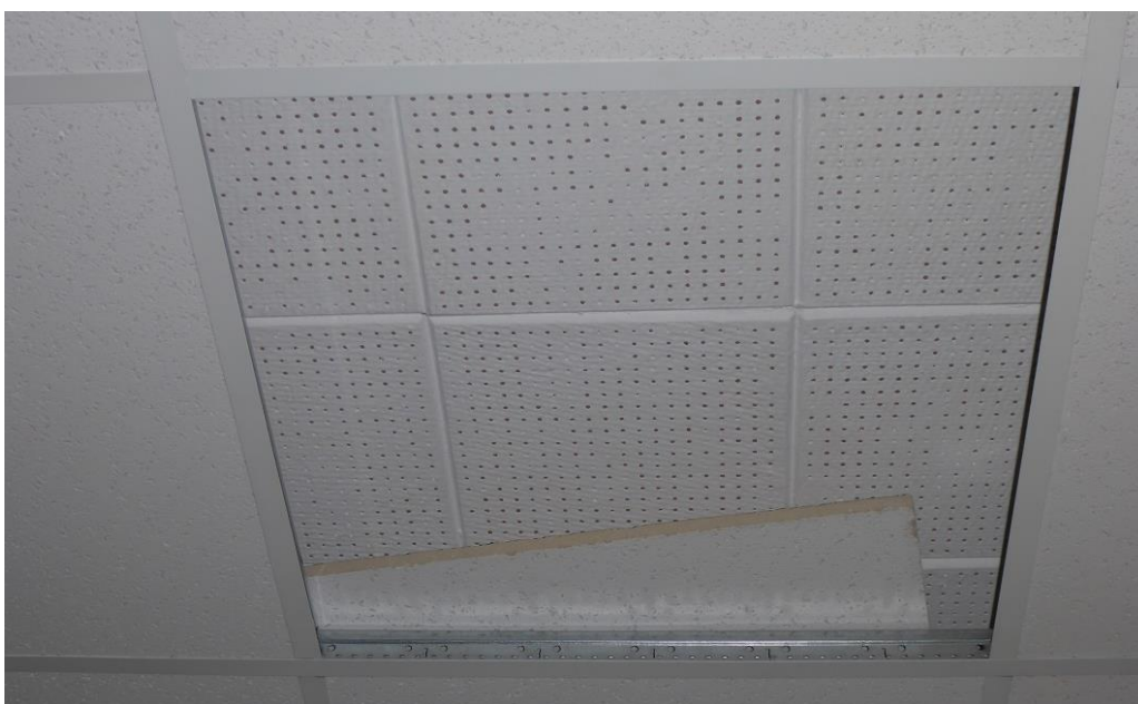
Płyty akustyczne przymocowane do stropu właściwego – parter
