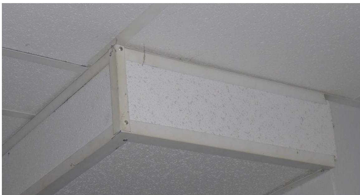
Prowizoryczne połączenia listew konstrukcyjnych sufitu – piwnica -1
