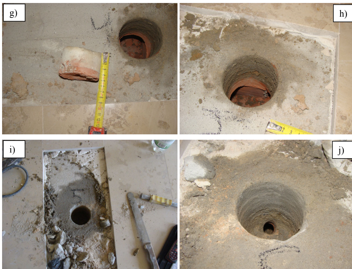
Fot. 1. Odkrywki warstw podłogowych: a, b) nr 1, c, d) nr 2, e, f) nr 3, g, h) nr 4 oraz i, j) nr 5
