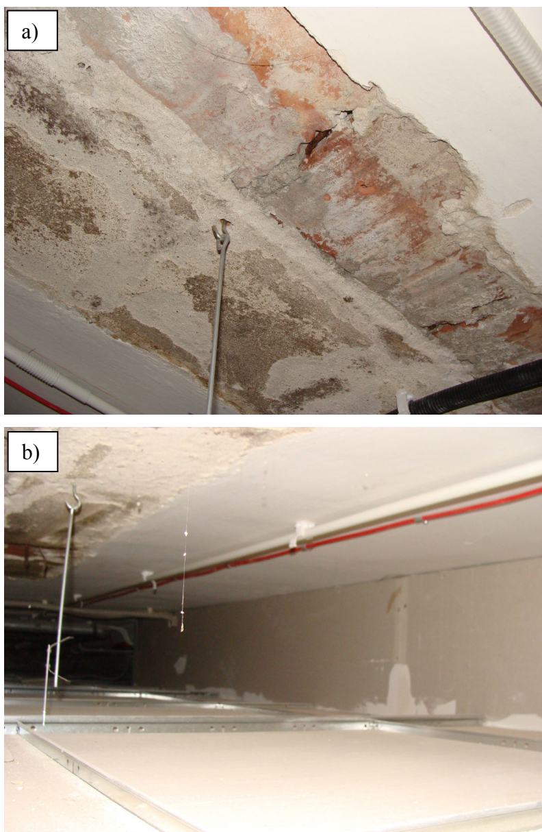
Fot. 2 a, b) Widok konstrukcji stropu Ackermana od spodu
